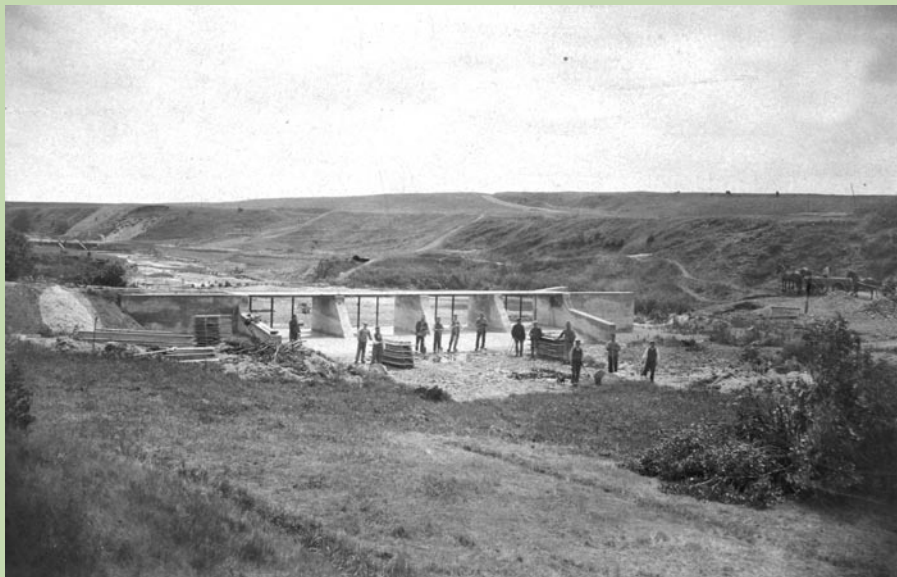
Fra etableringen af den eksisterende opstemning i 1911.
