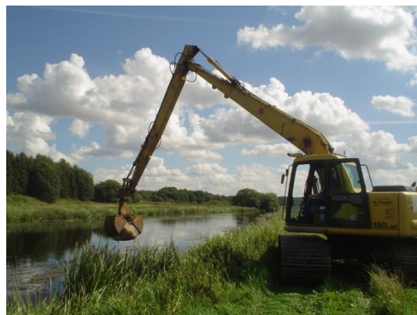
Figur 2: Stenene blev lagt ud med "langarmet" gravemaskine.
