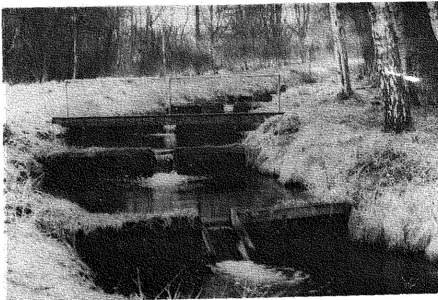
Fig. 4.1 Den gamle fisketrappe bestod af 28 lavvandede bassiner forbundet med små fald.
