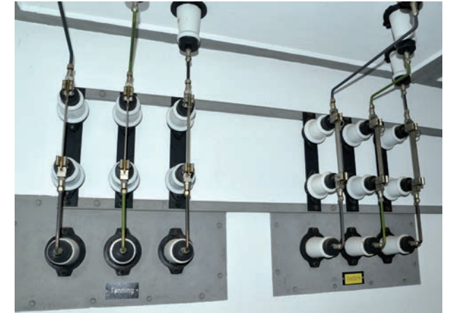
Kraftværkets indre fremstår flere steder som ved opførelsen og er i meget høj grad et fortællende kulturhistorisk anlæg.
