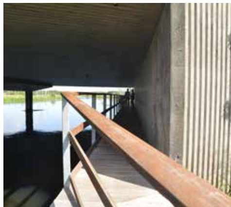
Gangbroen under Viborg Landevej
