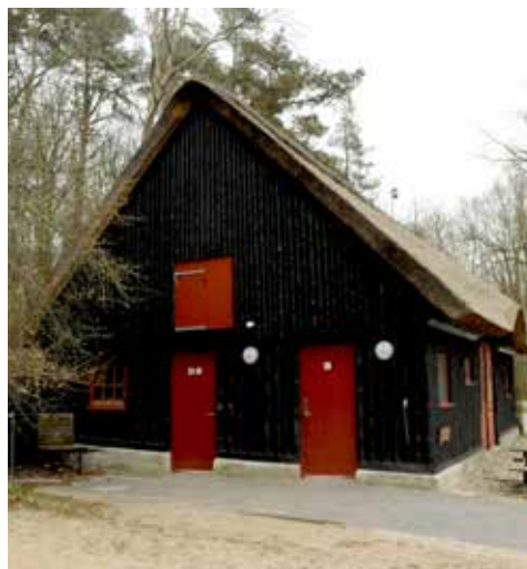
Toilet i Skovhuset
