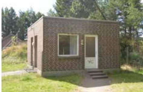
Toiletbygningen ved rensenanlægget
