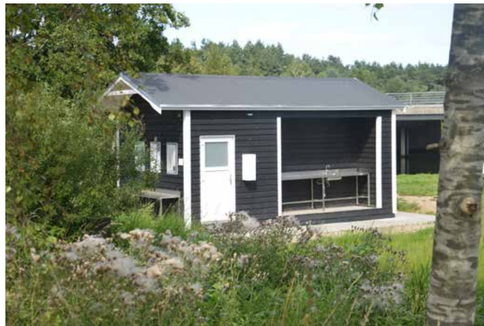
Ny toiletbygning ved Kongensbro
