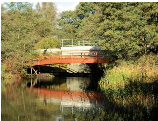
Den nye stibro set fra vandsiden
