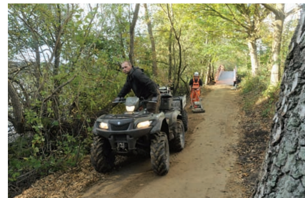
Fra etableringen af grusblægning på stier
