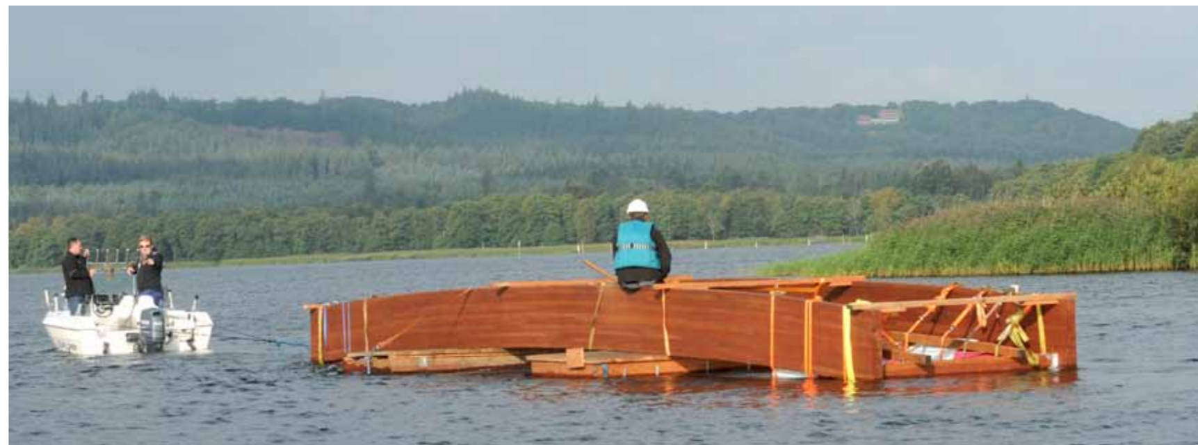
Fra udsejlingen af en ny stibro til Himmelbjerggruten – Himmelbjergtet i baggrunden
