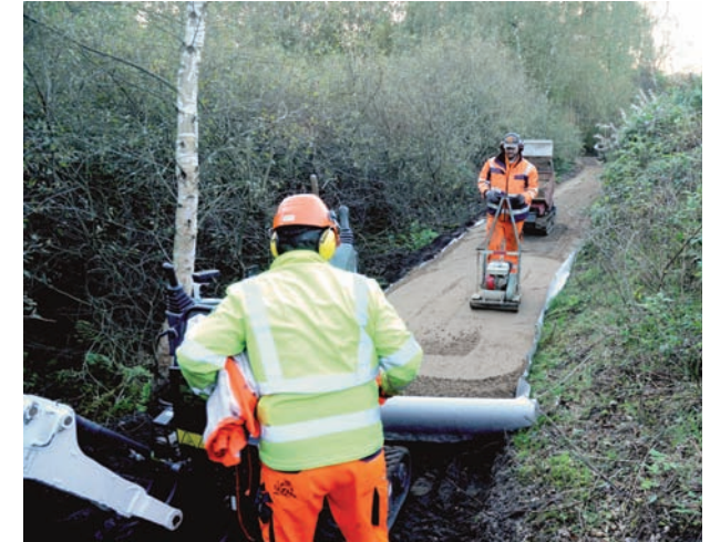
Himmelbjergruten, grusstier på geotekstil udført af Anton Kristensen ApS
