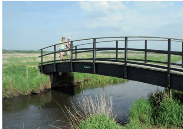
Nordkærbroen – bro over Gudenåen i Uldum Kær – udført af Woodways, værn og dæk i sibirisk lærk
