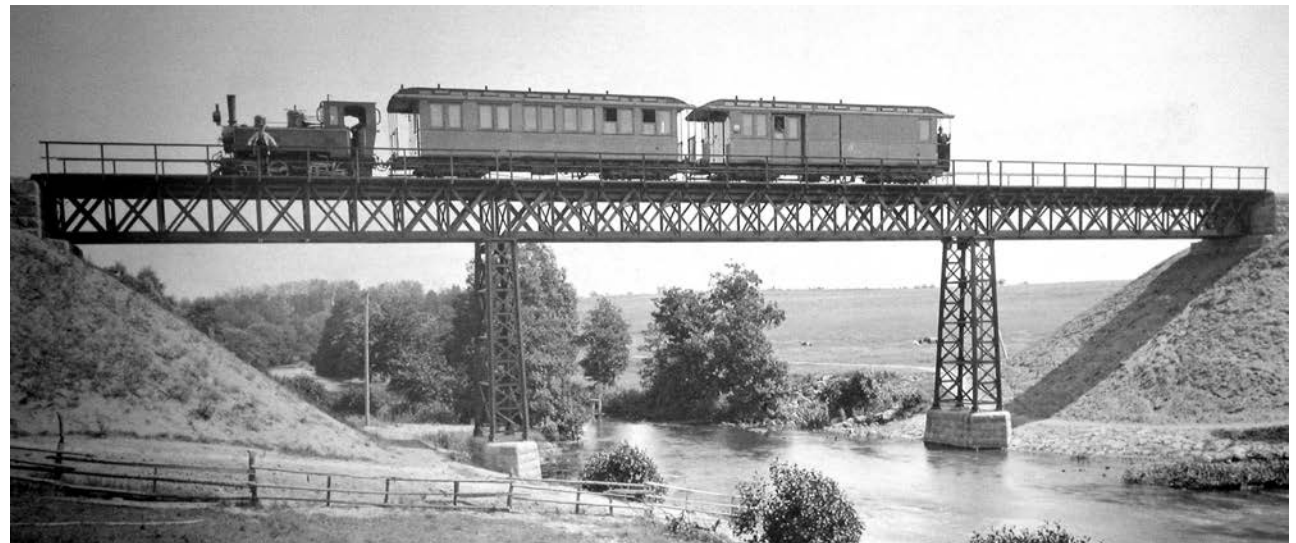
Jernbanebroen fra 1899 over Gudenåens hovedløb – blev i 1920'erne indlejret i en grusdæmning.
