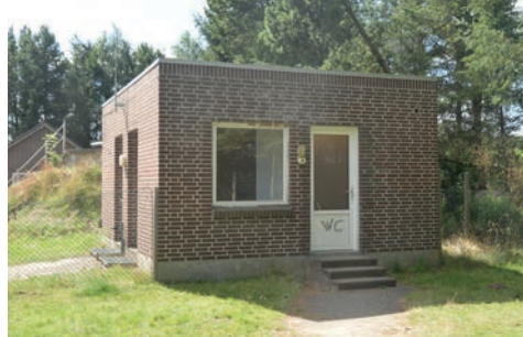
Toiletbygningen ved rensesanlægget
