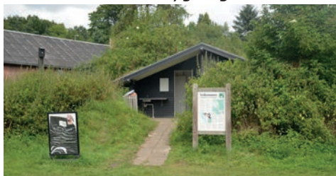
Eksisterende toiletbygning udskiftes
