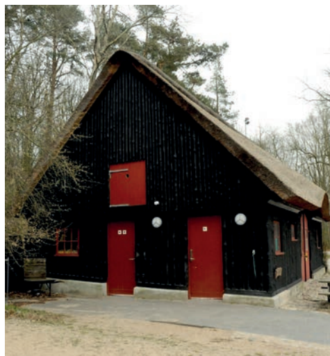
Toilet i Skovhuset
