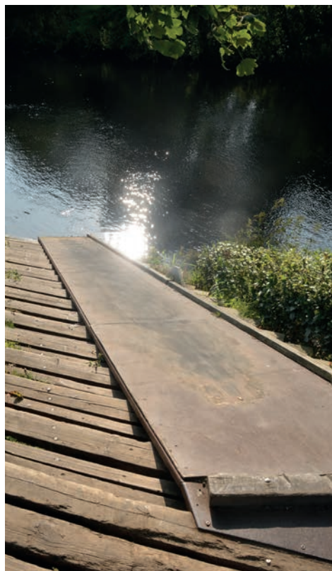
Rampe til isætning efter værket
