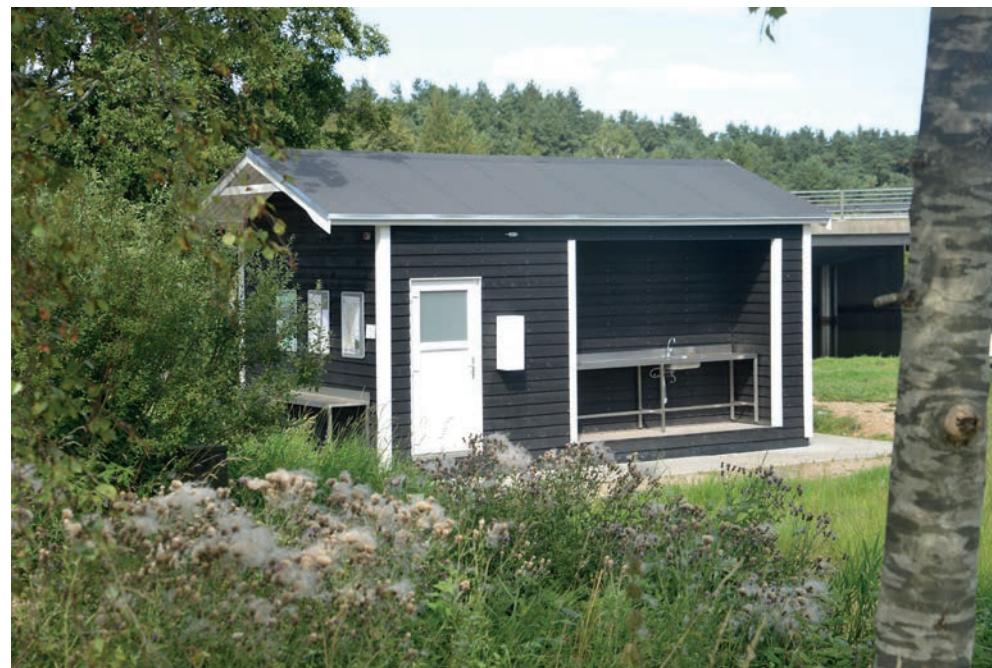
Ny toiletbygning ved Kongensbro
