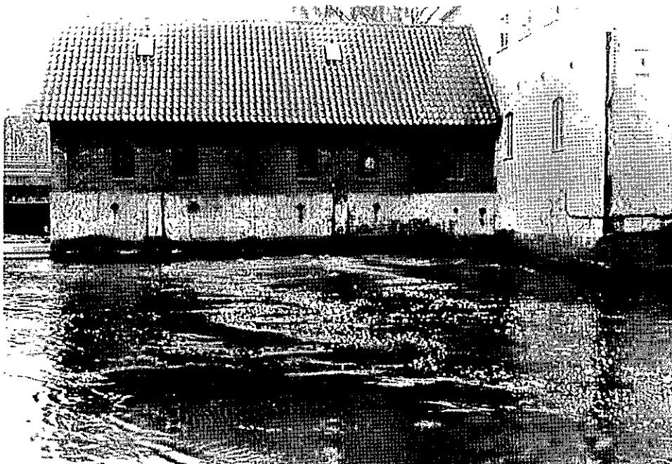
Ry Mølle: Maskinhuset set fra bagvandssiden.
