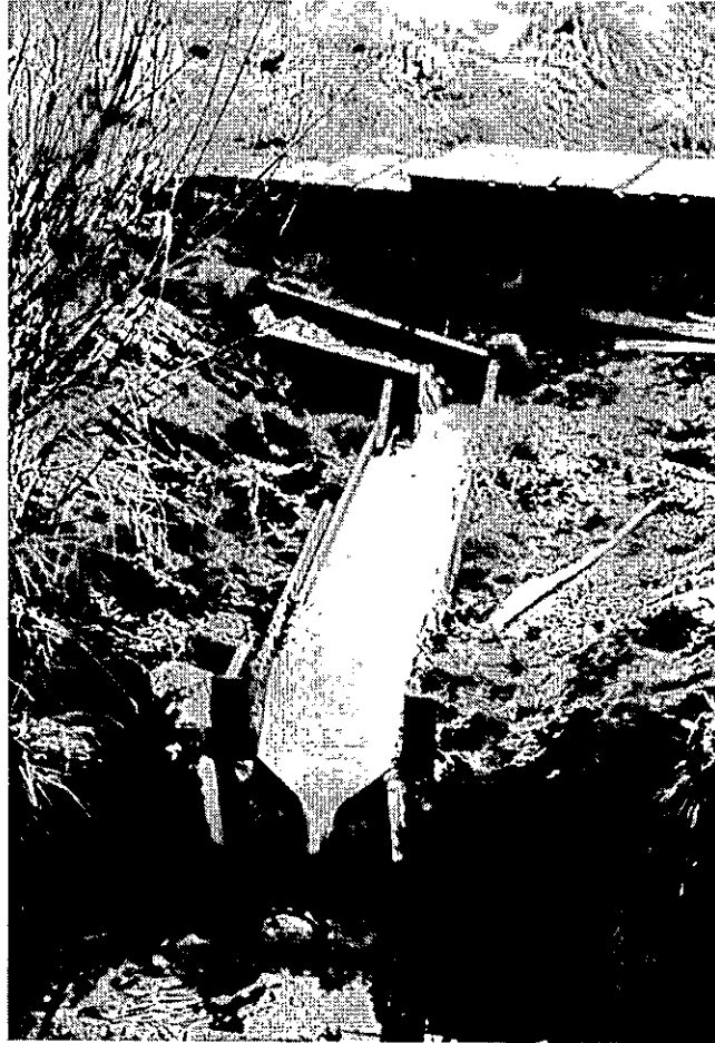
Fig. 5: Opsætning af overfaldsbygværk i afløbsrende.
